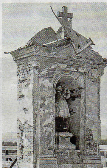
SOCHA SV. JANA NEPOMUCKÉHO stávala v Dolní Vltavici u mostu.
